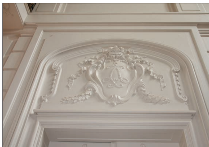
22Nauwkeurige herstelling van het lijstwerk met Renovation Mix
