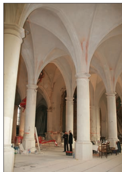
Het volledige interieur werd eerst blootgelegd en dan uitgeplamuurd
