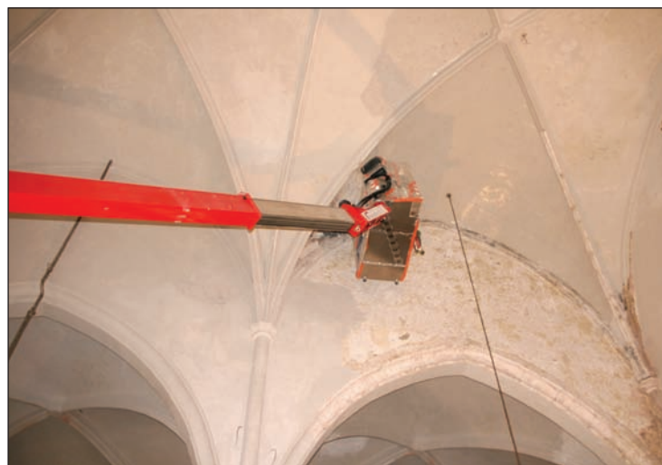
Na het uitplamuren wordt alles opnieuw geschuurd en ontstof
