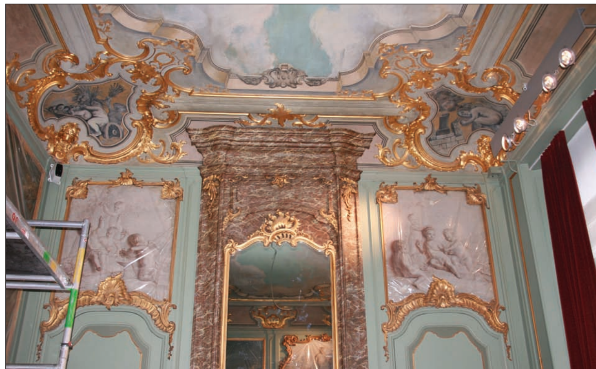
Minutieuze restauratie van het originele interieur op het gelijkvloers van het paleis
